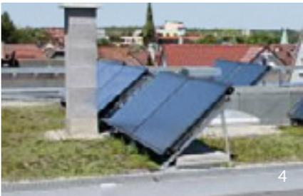
Die Flachkollektoren sind ideal geeignet für jede Art von Montage und machen dabei immer eine gute Figur – egal ob Dachintegration\* (1), Aufdachmontage\* (2), waagerechte Fassadenmontage (3) oder Flachdachmontage\* (4).
